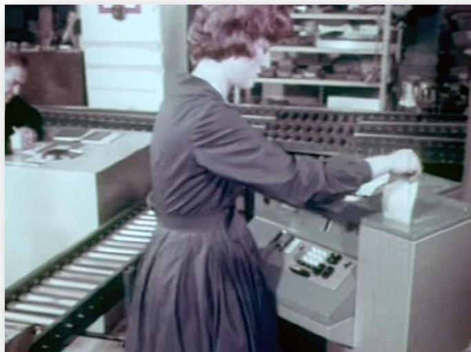
Un'operaia registra, tramite scheda perforata, l'ingresso in magazzino di nuovi componenti pronti al montaggio. I dati verranno gestiti dall'elaboratore a valvole ELEA 9002.
